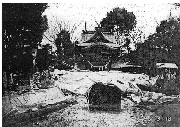
写-1 初島大社の被害状況
